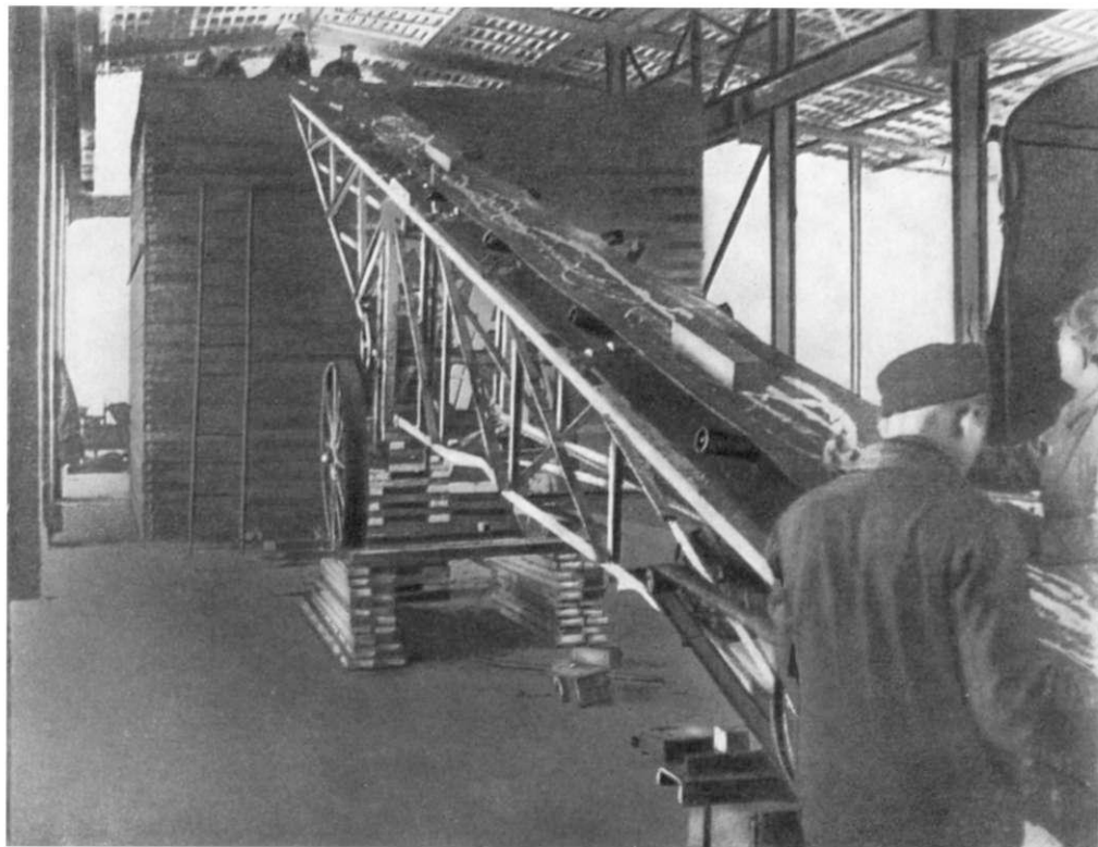
Рис. 5. Идет сборка 365-тонного куба из графита.
