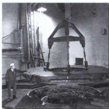
Поднятие центральной защитной плиты реактора
