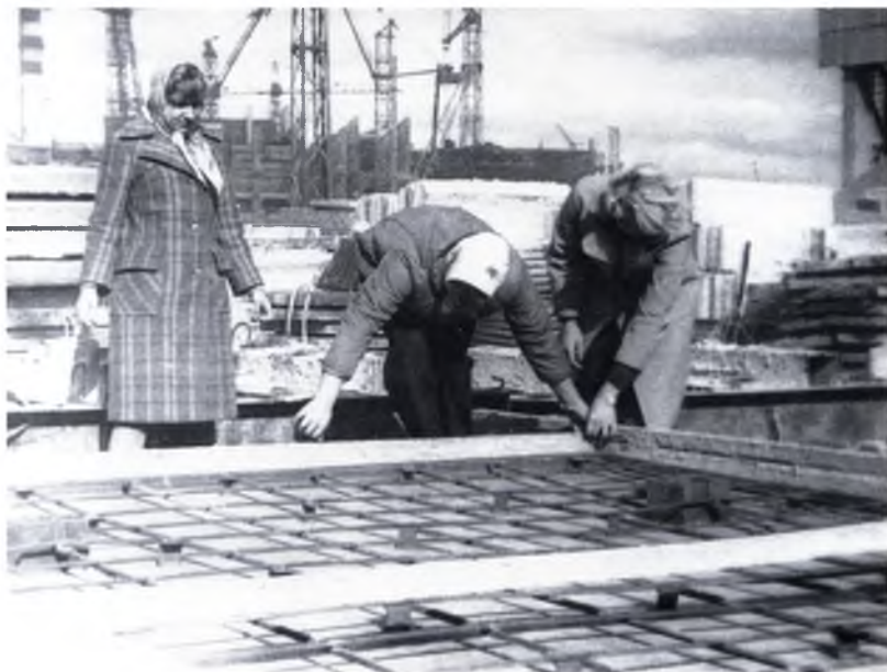
Изготовление железобетонных конструкций, 1977 г.
