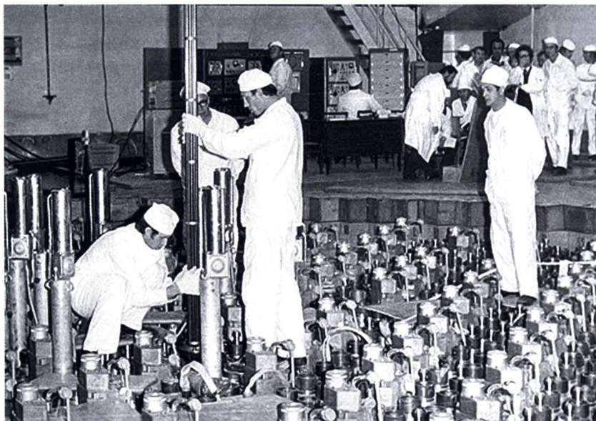
Загрузка первой тепловыделяющей сборки в ячейку технологического канала, 25 сентября 1976 г.
