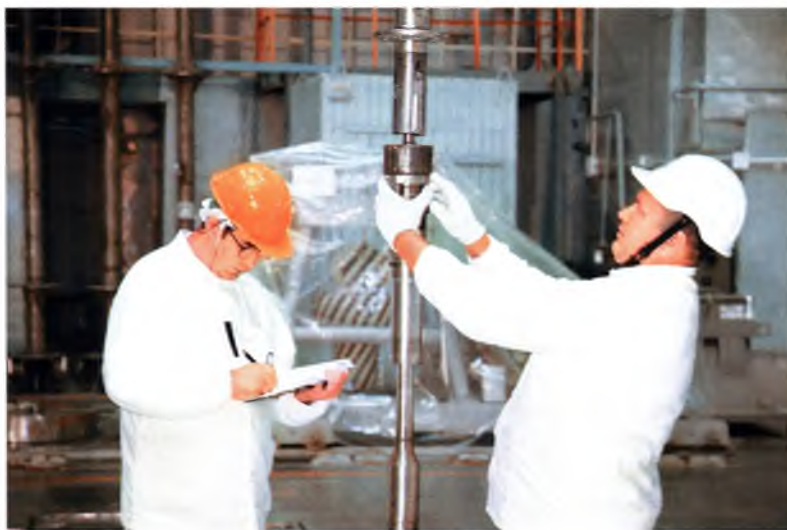
Установка технологических каналов в центральном зале второй очереди, 2009 г.
