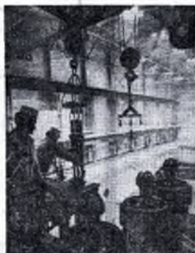
ИДЕТ ЗАПРАВКА РЕАКТОРА АТОМНЫМ ТОПЛИВОМ.
