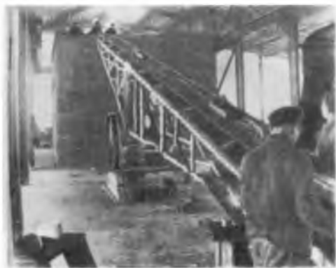
Сборка куба из графитовых брусков. 1945 г.
