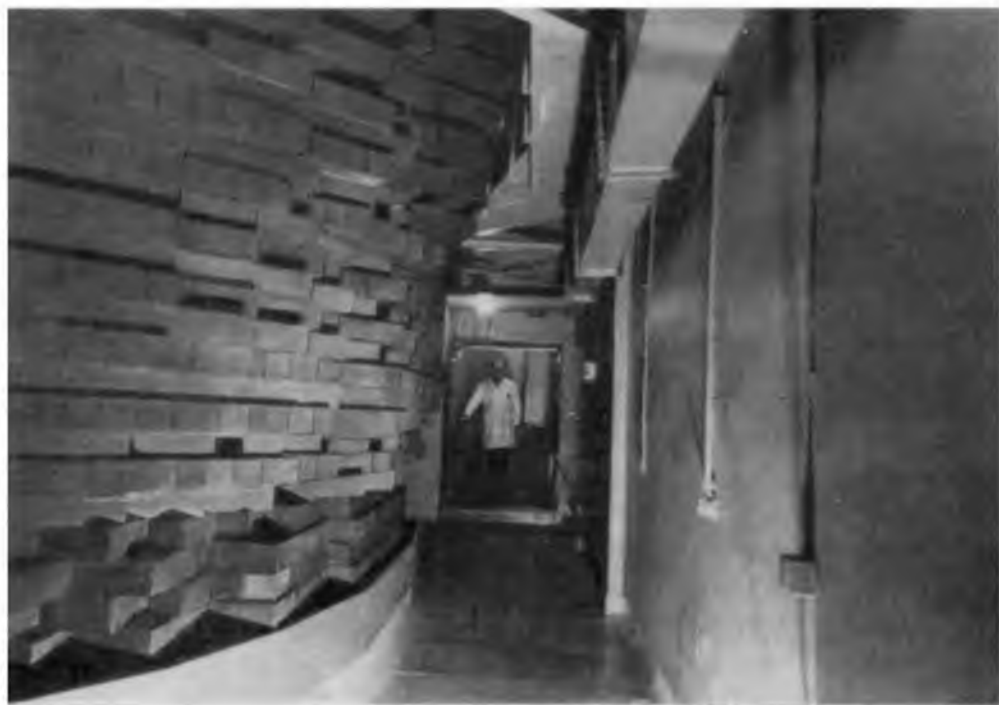
Рис. 4. Графитовая кладка реактора Ф-1
