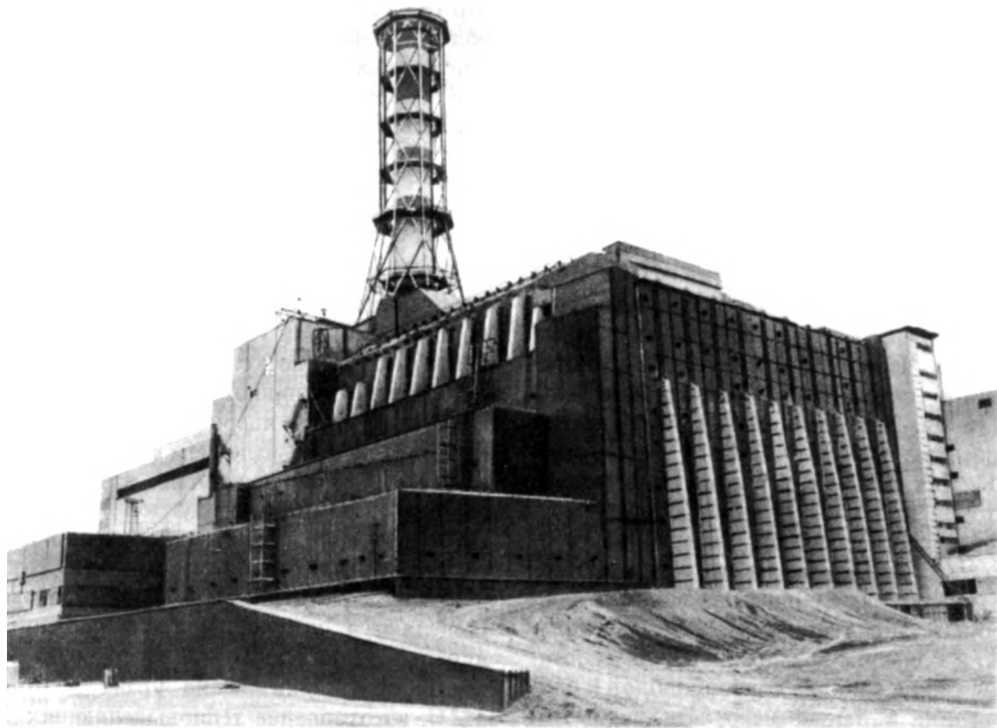
Рис. 5.3. Саркофаг IV блока Чернобыльской АЭС
